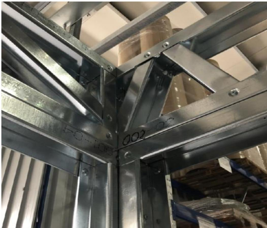
Le possibili lavorazioni al singolo profilo consentono la facile e precisa realizzazioni delle connessioni dei vari componenti strutturali (pareti, travi e solai).
